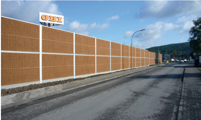
Lärmschutzwand Koko wall
