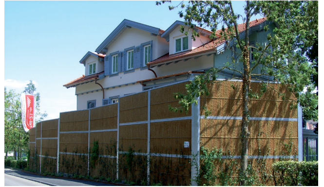
Lärmschutzwand Koko wall
