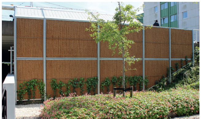
Lärmschutzwand Koko wall HA
