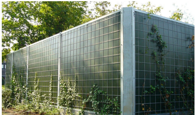
Lärmschutzwand Noise reducer
