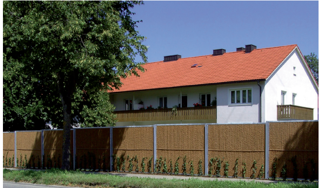
Lärmschutzwand Koko wall
