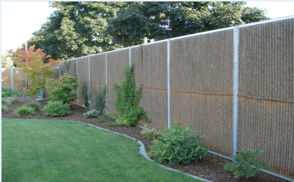
Lärmschutzwand Kokowall lite 2400 mm ca. zwei Jahren nach unserer Montage
