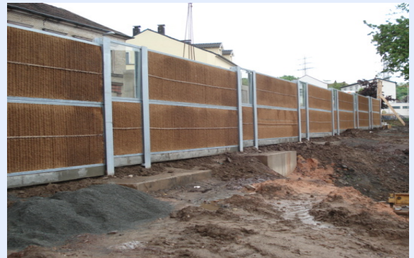
Lärmschutzwand Kokowall mit Fenster in Bauphase
