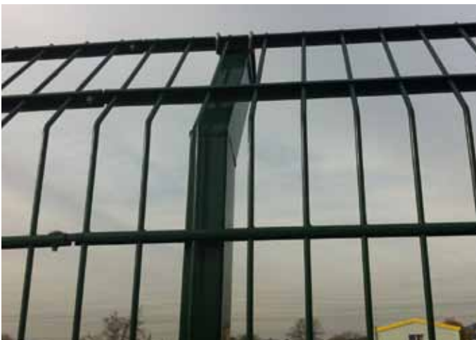
Detail Verletzungsschutz: Vermeidung von Unfällen durch einen glatten oberen und wahlweise unteren Abschluss
